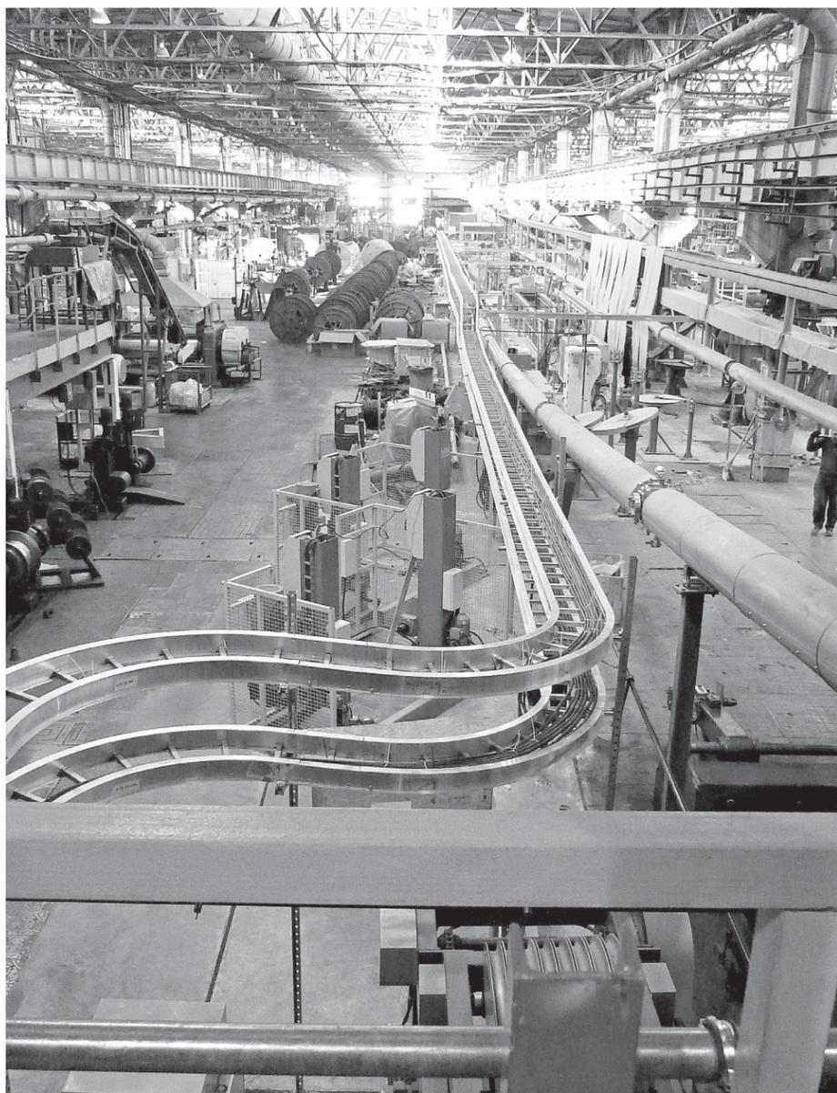
Механомонтаж практически завершен, оборудование выставлено на свои места. В настоящее время выполняется подключение систем энергоснабжения оборудования. Основные задачи будут теперь связаны с наладкой и запуском оборудования.
