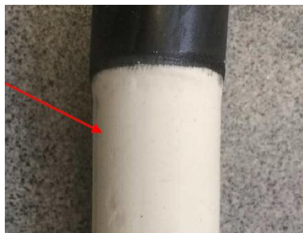
Рисунок 5 – Удаление электропроводящего экрана по изоляции на кабелях с изоляцией из невысокомодульной этиленпропиленовой резины.
