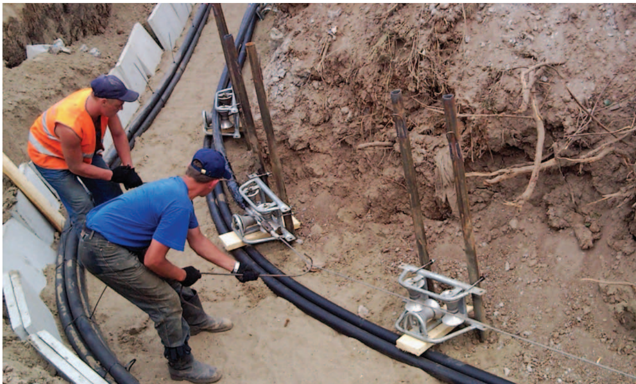
Процесс прокладки кабеля. Оттяжка крюками в повороте
